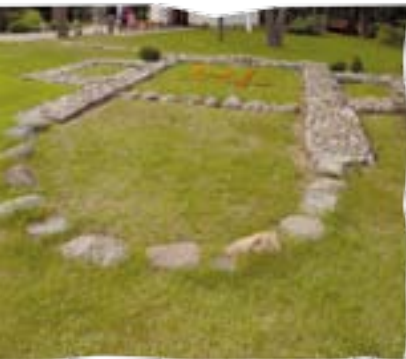
Fundamenty kaplicy z XIII w.
