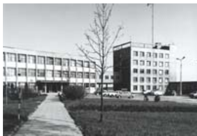
Budynek przy ul. Raławickiej
