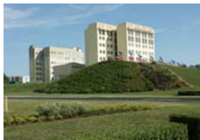
Budynek przy ul. Śniadeckich
