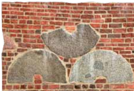
Mühlsteine in der mittelalterlichen Wehrmauer
