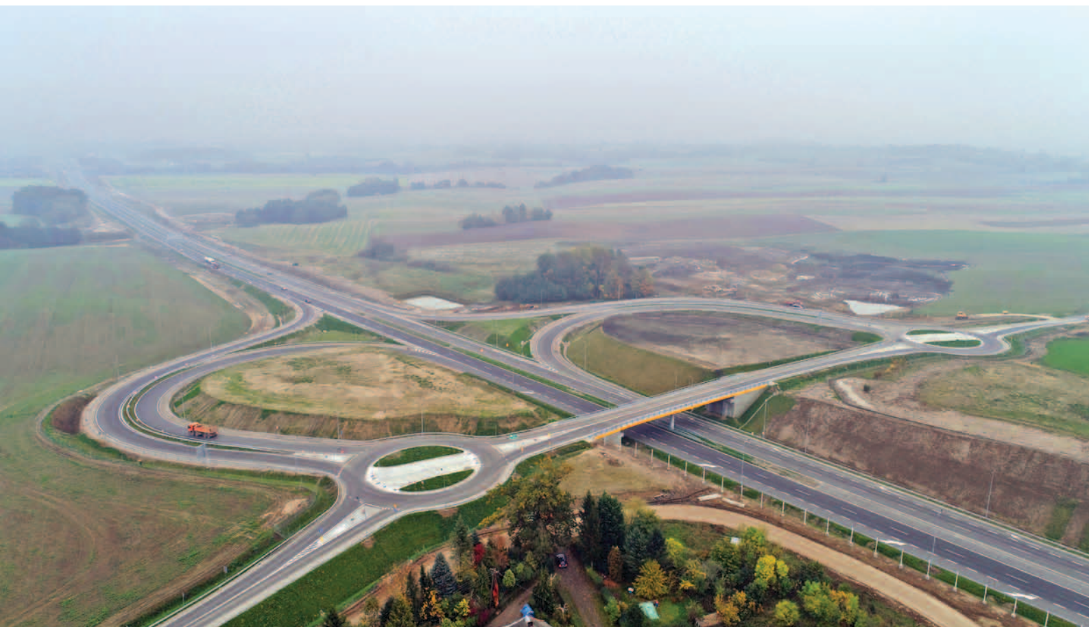
Węzeł Borkowice stanowi połączenie z trasą S6 drogi krajowej nr 11 i drogi lokalnej biegnącej w kierunku nadmorskiej miejscowości Pleśna.
